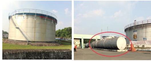
Hình 4. Bê hình trụ đứng và bê hình trụ nằm tại Tổng kho xăng dầu
