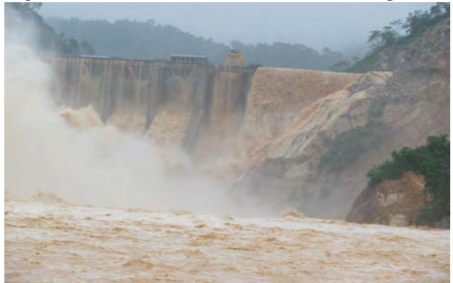
Đập Hồ Hồ (Hà Tĩnh) nước tràn qua đỉnh đập do không mở được cửa van khi lũ về
