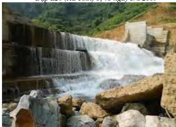
Đập thủy điện ĐăkRông 3 (Quảng Trị) bị vỡ ngày 7/10/2012
