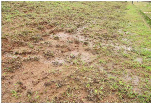
Đập Tân Sơn (Gia Lai) bị thấm mạnh ở mái thượng lưu
