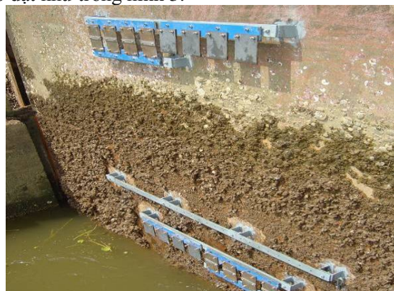
Hình 3. Lắp mẫu trên cửa van Diêm Điền
