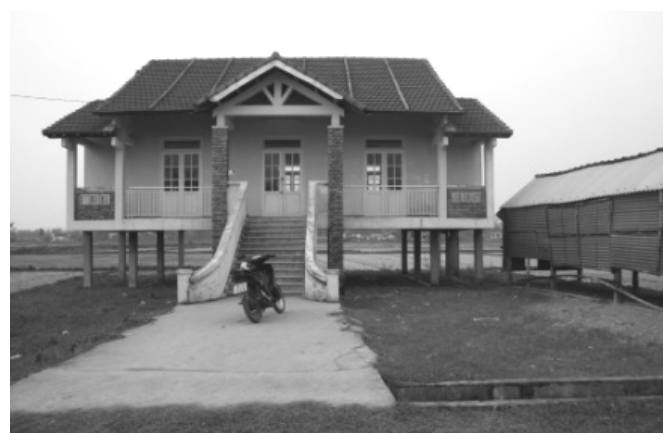
Hình 3: Công trình sơ tán dân kết hợp nhà sinh hoạt cộng đồng ở xã Quảng An, tỉnh Thừa Thiên Huế
