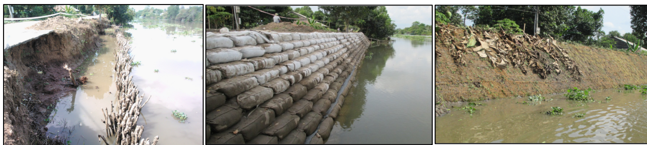
Hình 7: Hiện trạng khu vực thí điểm (trái), mái kè sau khi hoàn thiện xếp đặt bao (giữa) và mái kè sau khi phủ đất và trải thảm sơ dừa (phải)
