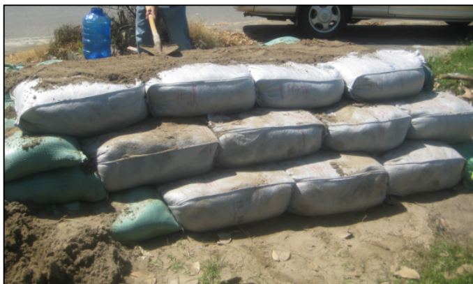
Hình 3: Bao cát sau khi được đổ đầy (trái), mái kè bằng bao cát thí điểm (phải).
