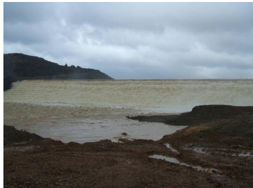
Dẫn dòng qua đập xây dựng dờ
