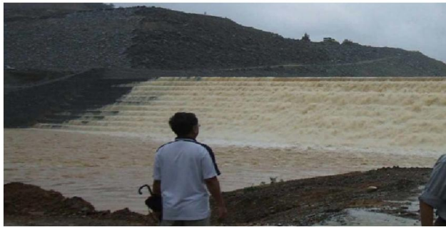
Khi nước bắt đầu tràn tập trung vào vai trái
