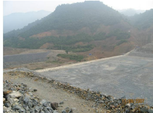
Thượng lưu phần chừa lại thân đập để dẫn dòng
