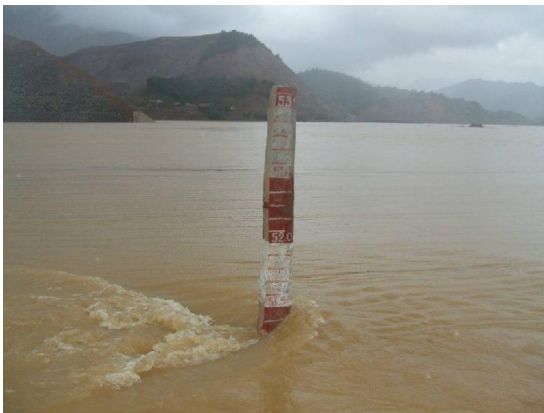
7h15 ngày 04/10/2007 lũ tràn qua đập xây dở và mực nước lũ (51.50m) ở cửa vào tại thời điểm 7h26
