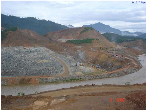
Dẫn dòng qua lòng sông thu hẹp năm thứ 1 (2005)
