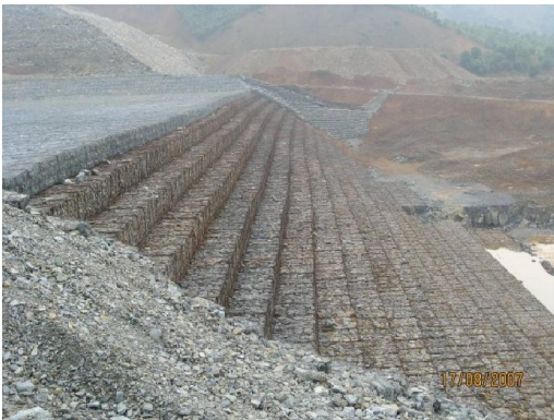
Bạc nước gia cố hạ lưu dẫn dòng qua đập xây dựng dờ
