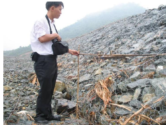
Mực nước cao nhất ở cuối tràn qua đập chính xây dở khoảng 50,00+0.90m theo vết lũ để lại (ảnh 06/11/2007)
