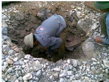
Hình 2. Đào hố thí nghiệm tại hiện trường khối đắp IIIA
