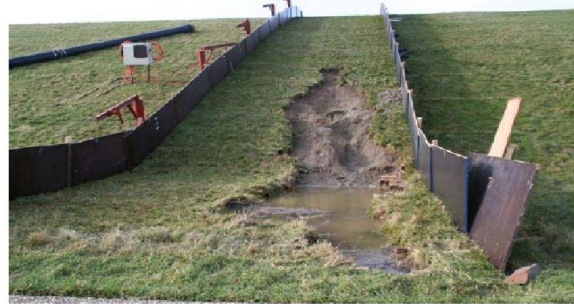
Hình 3: Thí nghiệm hiện trường sóng tràn gây xói mái đê phía trong đê biển Hà Lan
