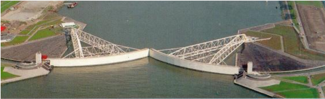
Hình 1: Đập Maeslant ở trạng thái bắt đầu đóng kín cửa
