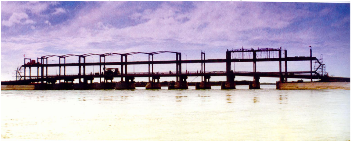
Hình 3: Đập ngưỡng thấp Ba Lai (Bình Đại, Bến Tre)
