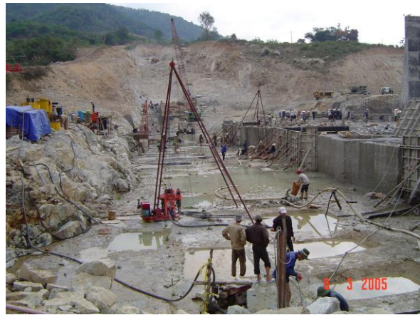
Hình 4. Khoan phụt xử lý nền đập
