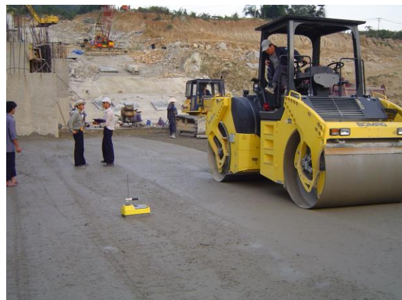
Hình 2. Rải, san và đầm bê tông trên mặt đập
