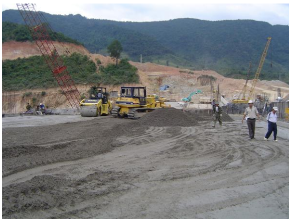
Hình 2. Rải, san và đầm bê tông trên mặt đập
