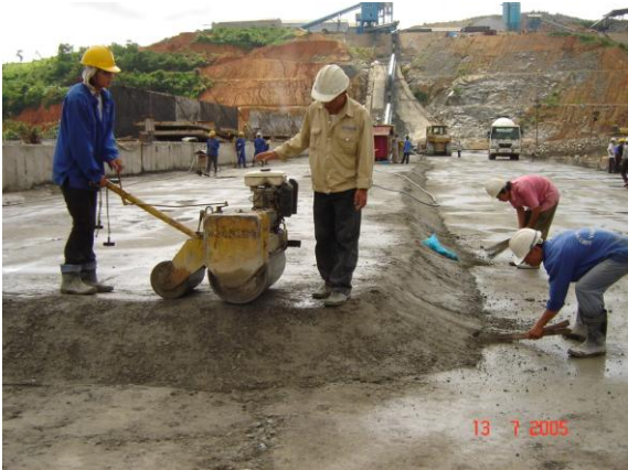
Hình 8. Thi công khe tiếp giáp giữa các khối đổ đập Pleikrông
