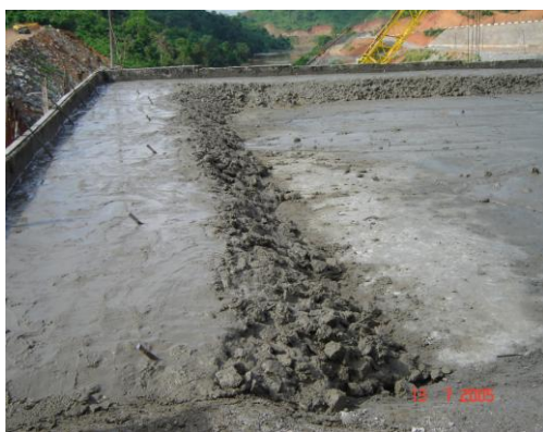
Hình 11. Thi công tiếp giáp giữa RCC với bê tông thường ở đập Pléikrông
