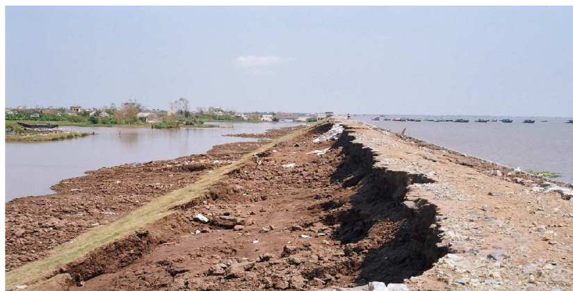
Hình 1. Đê biển sau khi xảy ra nước dâng do bão (Đoàn Văn Long)
