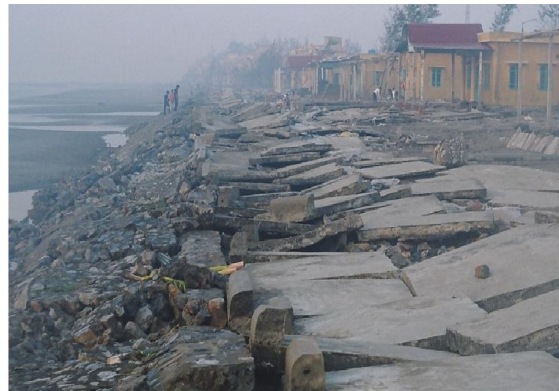
Thịnh Long (Nam Định) revetment after typhoon 7/2005
