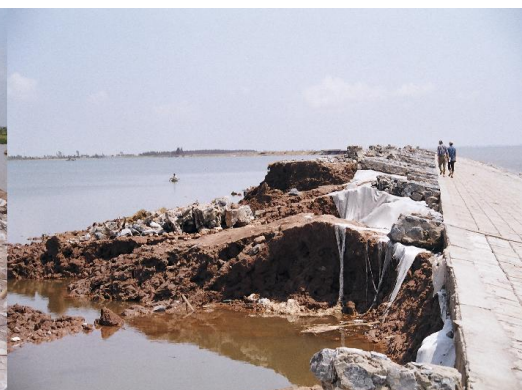
Hình 25. Cao trình đê bị hạ thấp tại những đoạn đê đắp bằng đất thịt
