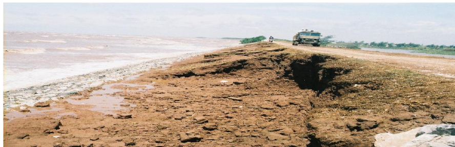
Hình 3. Sóng leo và nước dâng gây trượt mái đê phía biển
