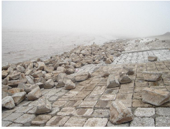
Hình 15. Cầu kiện bị sóng đánh trôi dạt trên mái kè
