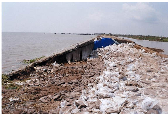
Hình 25. Cao trình đê bị hạ thấp tại những đoạn đê đắp bằng đất thịt
