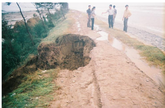
Hình 24. Sóng tràn qua gây sạt lở đê từ trong đồng
