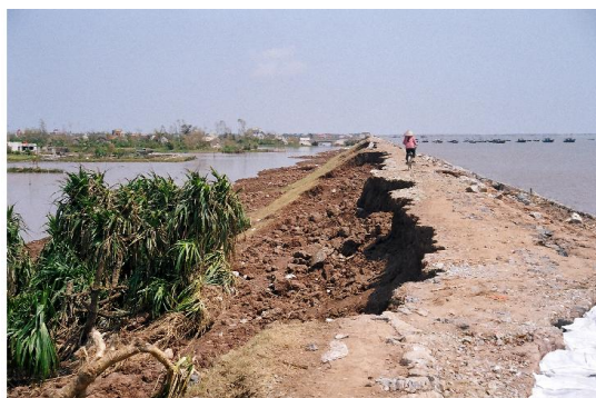
Hình 24. Sóng tràn qua gây sạt lở đê từ trong đồng
