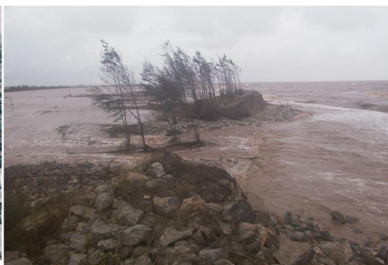
Hình 23. Sóng tràn qua và gây vỡ đê Táo khoai Hải Hậu
