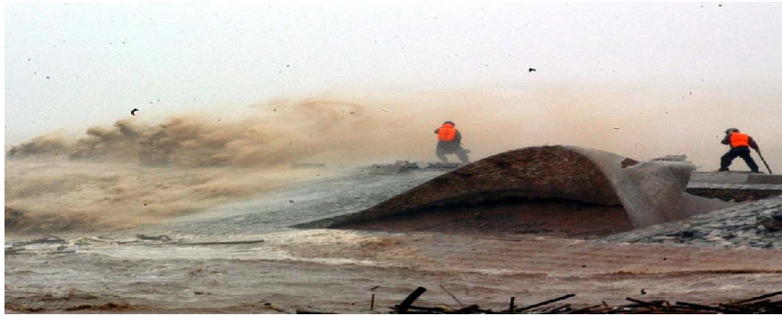
Hình 5. Sóng tràn qua đỉnh đê có không có tường chắn sóng
