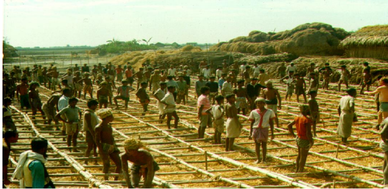
Hình 5: Thi công mông gia cố nền bằng tre
