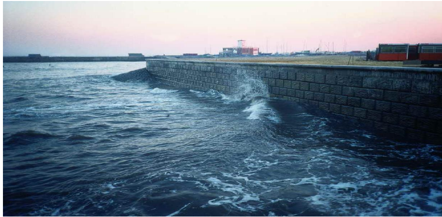
Hình 11. Kết cấu Tensar bảo vệ bờ bến cảng
