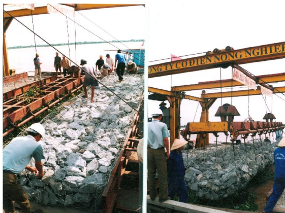
Hình 20. Thi công thả thềm đá dưới nước
