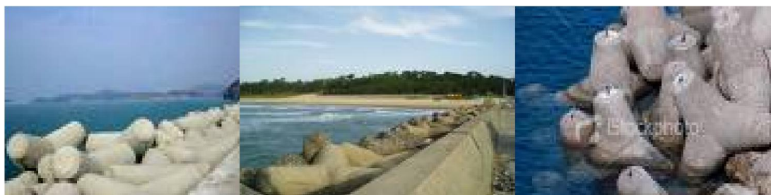
Hình 14. Ứng dụng khối dị hình xây dựng đê ngầm
