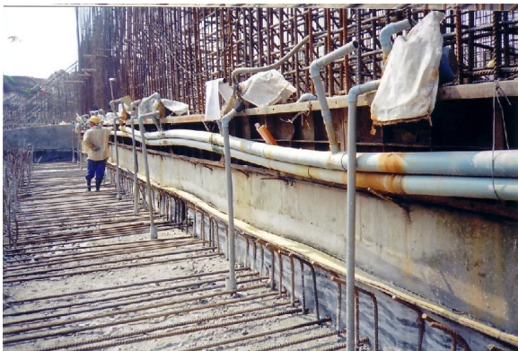
Hình 7: Bố trí giếng của Công ty xây dựng công trình thủy lợi Hải Phòng cho hố móng Vân Cốc
