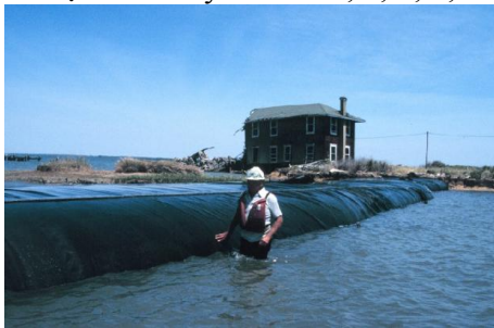
Hình 1: Sử dụng túi vải địa kỹ thuật tại đảo Barren, Nam Carolina, Hoa Kỳ Công trình có tác dụng phá sóng, bảo vệ bờ biển đảo Barren
