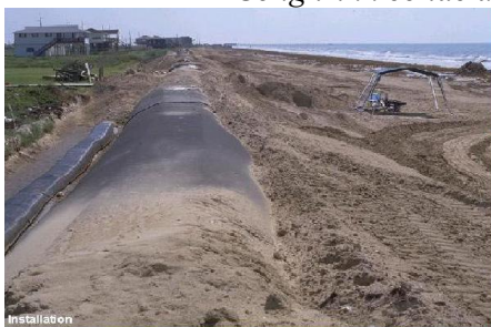
Hình 2: Sử dụng túi vải địa kỹ thuật tại bãi biển bang Texas, Hoa Kỳ Công trình có tác dụng chống xói lở, bảo vệ khu dân cư
