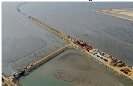
Hình 3: Sử dụng túi vải địa kỹ thuật xây dựng cảng tại Busan, Hàn Quốc Trong đó phần đường dẫn ra cảng được xây dựng hoàn toàn trên túi vải địa kỹ thuật
