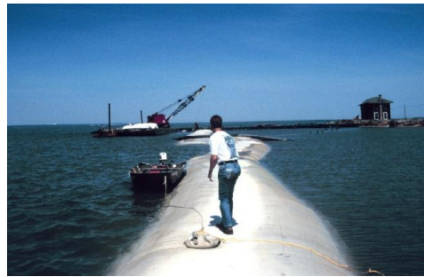
Hình 1: Sử dụng túi vải địa kỹ thuật tại đảo Barren, Nam Carolina, Hoa Kỳ Công trình có tác dụng phá sóng, bảo vệ bờ biển đảo Barren
