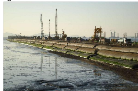
Hình 3: Sử dụng túi vải địa kỹ thuật xây dựng cảng tại Busan, Hàn Quốc Trong đó phần đường dẫn ra cảng được xây dựng hoàn toàn trên túi vải địa kỹ thuật
