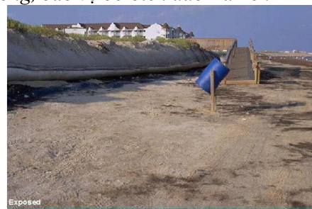
Hình 2: Sử dụng túi vải địa kỹ thuật tại bãi biển bang Texas, Hoa Kỳ Công trình có tác dụng chống xói lở, bảo vệ khu dân cư
