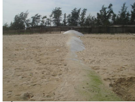
Hình 5: Sử dụng túi vải địa kỹ thuật tại bãi biển Hoà Duân, Phú Thuận, Thừa Thiên Huế (Công trình có tác dụng phòng chống xói lở, bảo vệ bờ)
