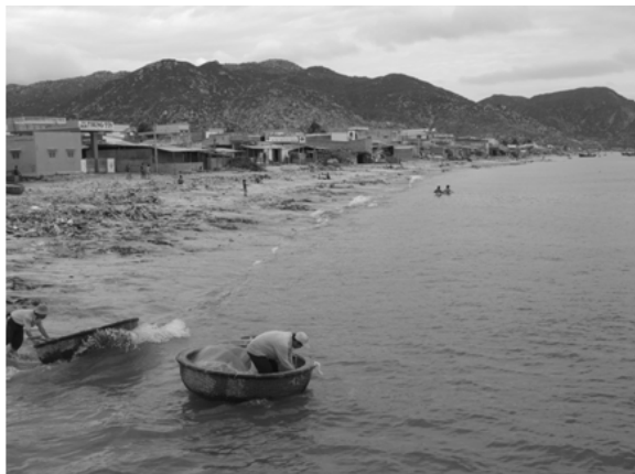
Hình 2: Hiện trạng sạt lở bờ biển xã Phước Diêm, huyện Thuận Nam
