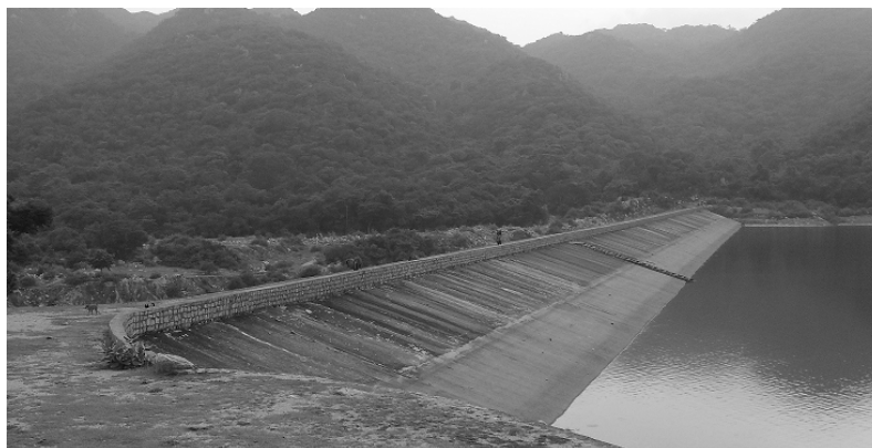
Hình 5- Toàn cảnh mái thượng lưu đập ví i bñn mặt b a t<ng.
