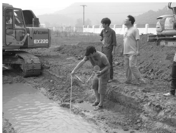
Hình 6. Đo kiểm tra chiều sâu hào
