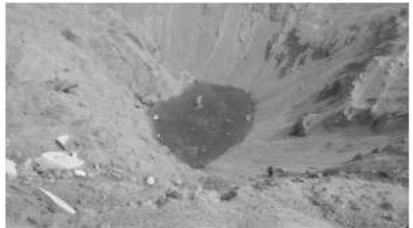
Hình 9. Hố sụt sâu khoảng 10m
