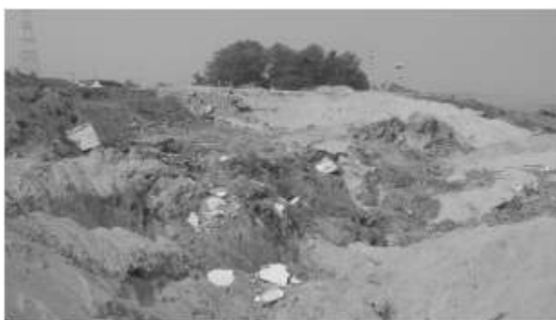
Hình 7. Hình ảnh khối trượt nhìn lên đỉnh đê Hữu Hồng.
