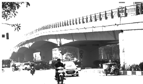
Hình 2. Cầu vượt tại nút giao Nguyễn Chí Thanh - Kim Mã, Cầu được xây dựng theo công nghệ dầm thép lắp ghép lớn nhất Việt Nam và là cầu vượt bằng thép thứ 7 tại Hà Nội.
