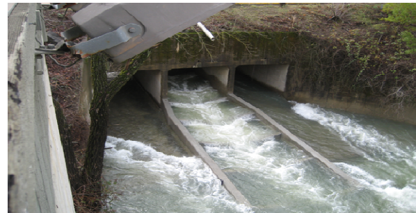
Hình 8. ĐDCQĐ dạng ống ngầm (nguồn: Thorncraft and Harris, 2000)
