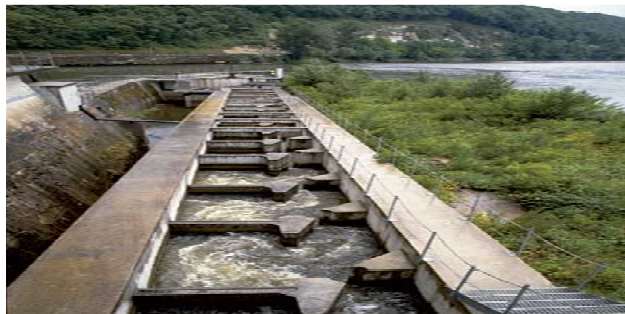
Hình 2. ĐDCQĐ dạng “khe dọc thẳng đứng” (Nguồn: Thorncraft and Harris, 2000)
