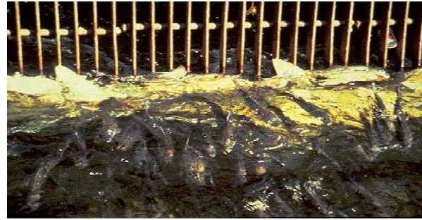
b) Hàng rào chắn tại nhà máy thủy điện trên đảo Loch Ness ở Scotland
