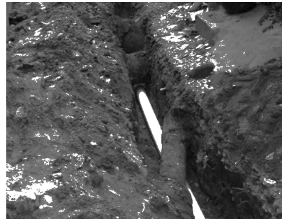
Hình 1. Ống cấp nước đi dưới cống thoát nước ở đô thị Tp. Hồ Chí Minh
