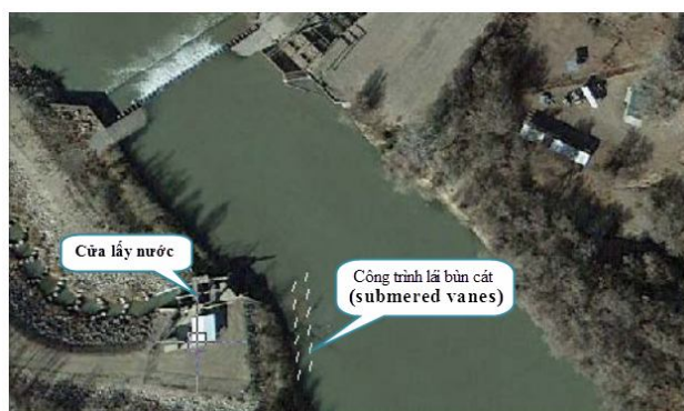
Hình 1. Công trình chống bồi lắng (dạng van ngầm - submerged vanes) tại cửa lấy nước bên sông San Juan River- New Mexico
