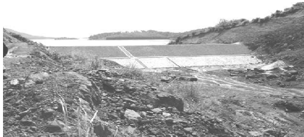
Hình 1. Đập tràn sự cố hồ Yên Lập
