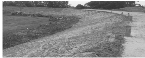
Sau khi thi công xong
