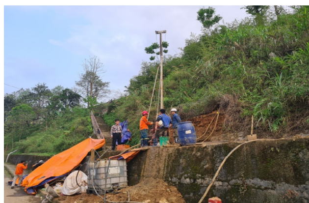
b) Quá trình khoan và lắp đặt trạm Tĩnh Túc
