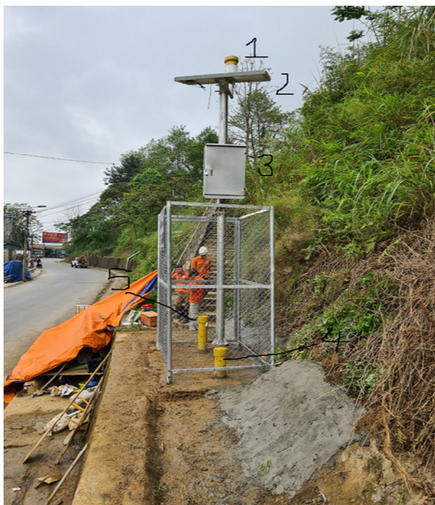
Hình 9. Trạm Tĩnh Túc sau khi hoàn thành lắp đặt (3/2021)
