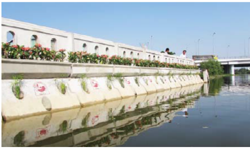
(a) Kè Rạch nước lên - TP Hồ Chí Minh
