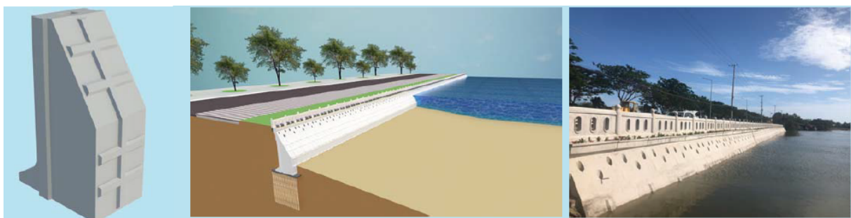
Hình 5. Dạng cấu kiện, Hình 3D và hình ảnh công trình kê bờ sông Dinh - Vũng Tàu
