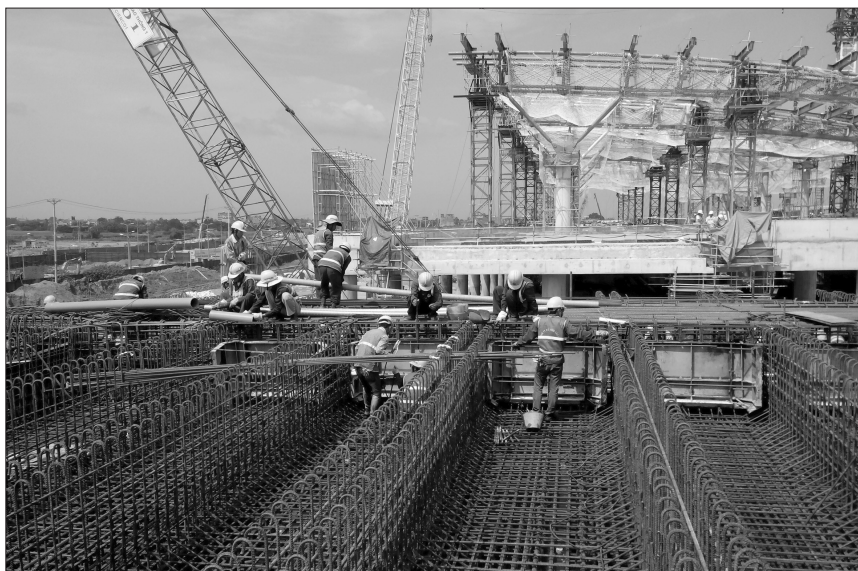
Công ty đang thi công cầu dầm nhà ga T2 Nội Bài
