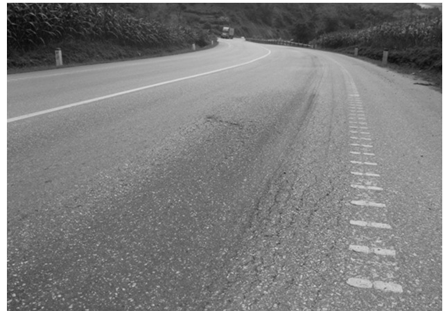
Hình 1: Vết lún bánh xe trên QL1A, đoạn Hà Nội - Lạng Sơn
