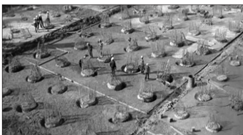
Hình 1: Thi công cọc khoan nhồi
