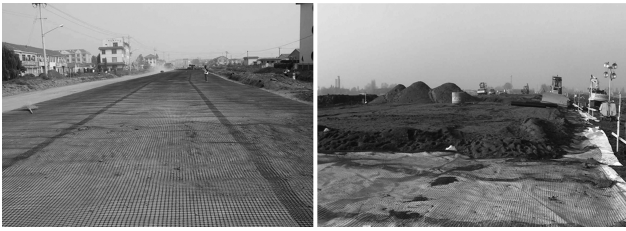
Hình 4: Thi công nền đường tại Làng Văn hóa Việt Nam, Q.9, TP.HCM [3]
