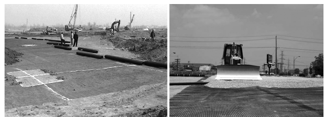
Hình 3: Thi công rải lưới hai phương polymer dưới nền đường
