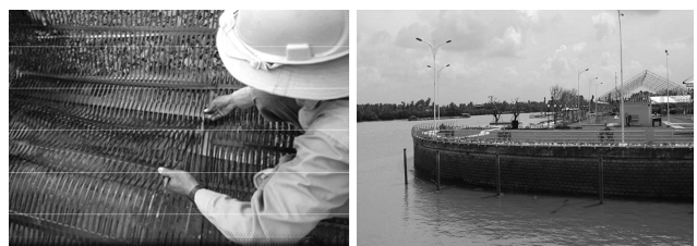
Hình 9: Công nhân rải lưới địa kỹ thuật
