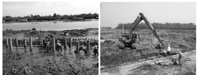
Hình 8: Chuẩn bị mặt bằng, thi công hệ cọc neo
