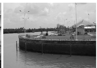
Hình 10: Công trình hoàn thành
