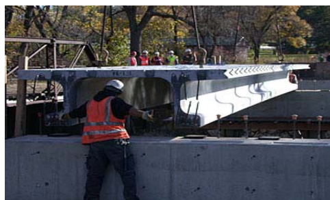
Hình 1. Dầm có nhịp 30m, sử dụng bê tông tính năng siêu cao, Buchanan County, Iowa, Mỹ.
