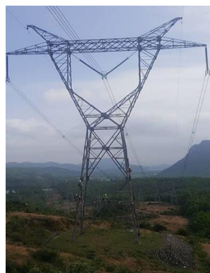
Hình 1. Cột điện đường dây 500 kV
