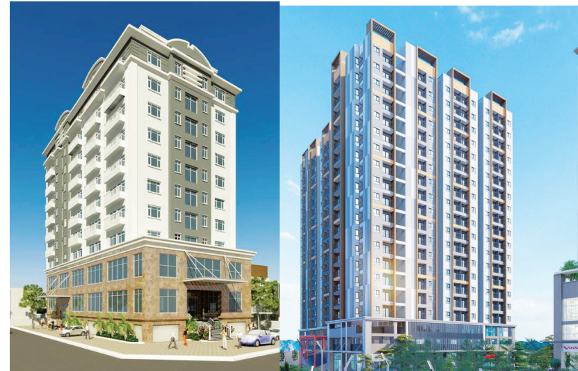
Công trình Nhà ở công vụ cơ quan Bộ Tư lệnh Công binh
