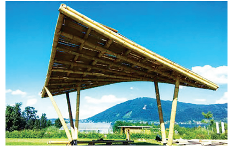
Mái dạng hypar được xây dựng tại, Altmünster (Áo) 2016 [5]
