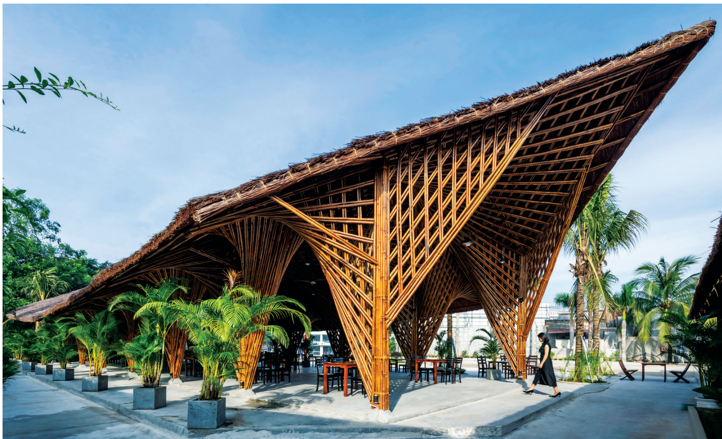
Hình 8. Cột chống ghép từ các mặt Hypar và kiến trúc khu sảnh nhà hàng [16]
