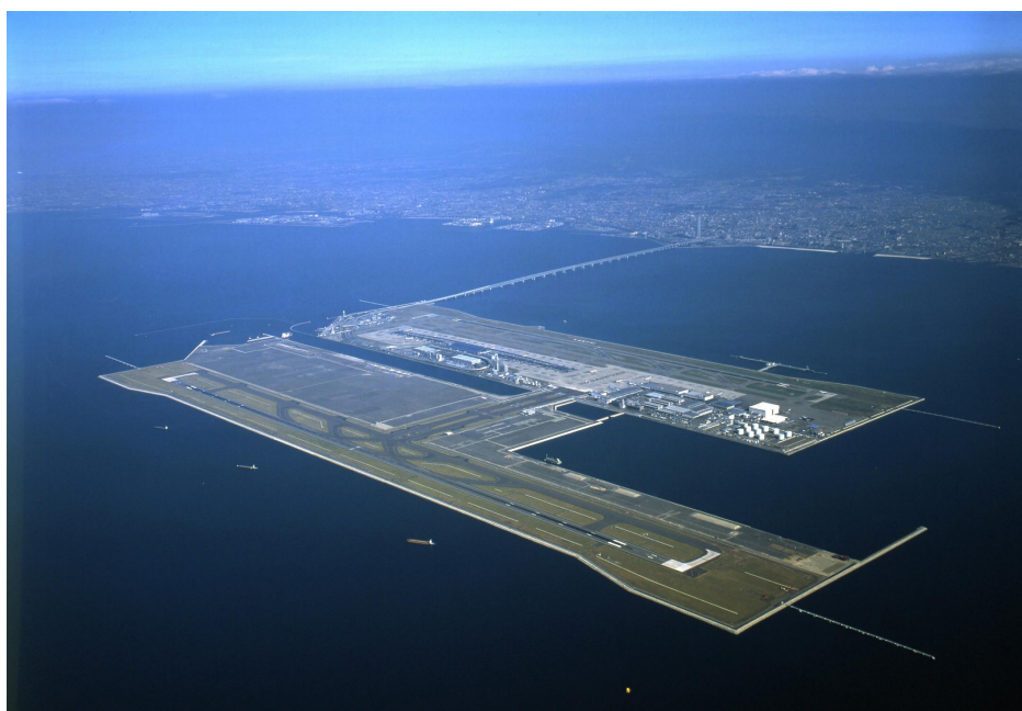
Sân bay Kansai (Osaka, Nhật Bản) được xây dựng trên đảo nhân tạo
