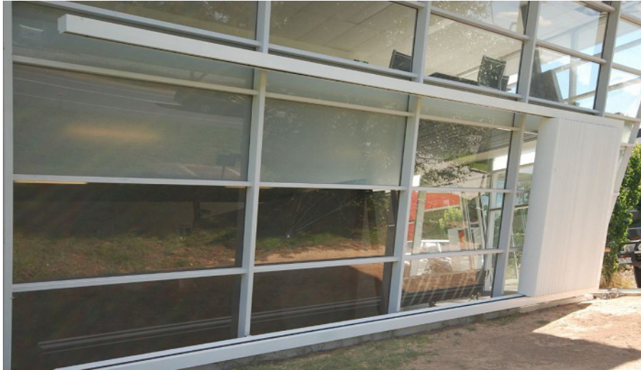
Hình 7. Hệ lam 3 chế độ tại Úc lúc xếp gọn để mở rộng tầm nhìn
