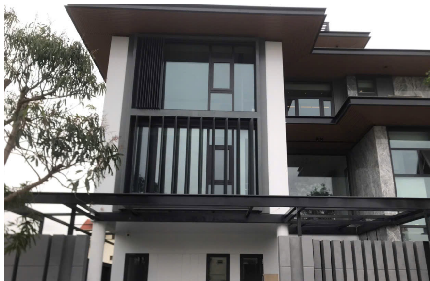
Hình 9. Lam chắn nắng 3 chế độ lúc xoay góc lam - công trình Hải An, Hải Phòng
