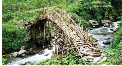
Giải pháp thiết kế cầu qua suối tại Chambok bằng vật liệu thân thiện môi trường - tre. (Nguồn: ICEM, 2023: 81, 82)
