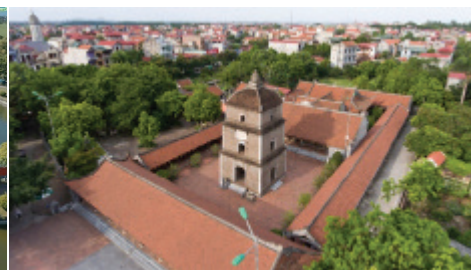
Chùa Dâu, Bắc Ninh - Sử dụng tường của 3 dãy hành lang làm tường bao
