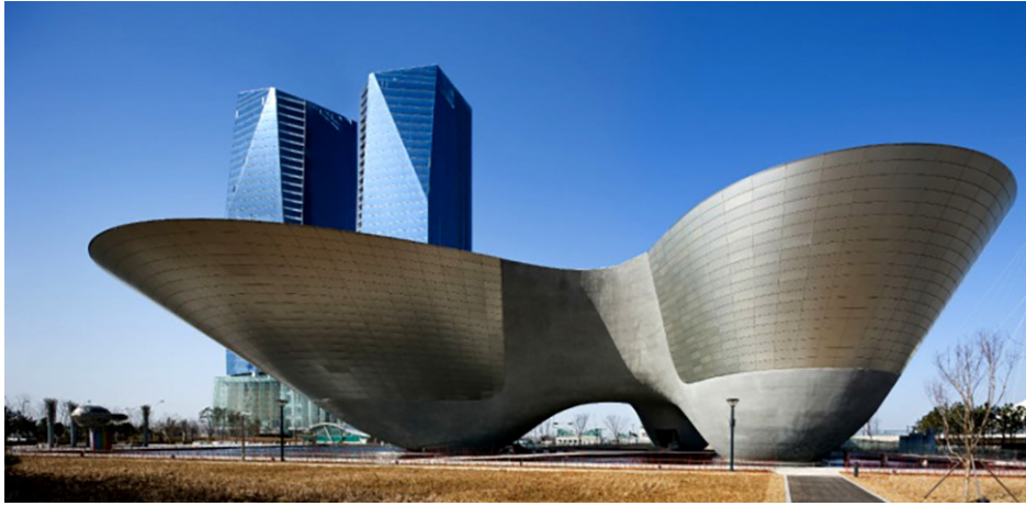
Công trình triển lãm Incheon Tri-bowl, Incheon, Hàn Quốc, là một biểu tượng văn hóa mới của Công viên - khu kinh tế tự do Incheon, Hàn Quốc.
