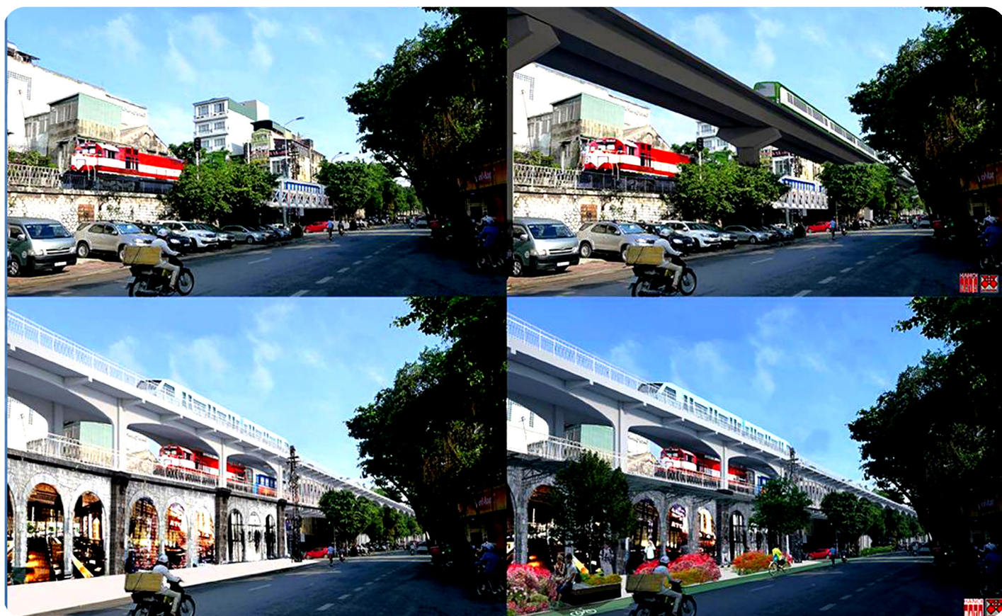
Hiện trạng đường sắt quốc gia trên cầu dẫn. Phương án xây dựng đường sắt đô thị có cột bê tông cốt thép trên vỉa hè Phùng Hưng được thiết kế năm 2014. Phương án tích hợp đường sắt quốc gia, đường sắt đô thị, phố thương mại, dịch vụ, du lịch kết hợp nâng cấp kiến trúc cảnh quan đường biên khu phụ cận Hồ Gươm.
