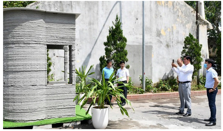
Nhà in 3D bê tông do Viện Vật liệu xây dựng nghiên cứu, chế tạo.
