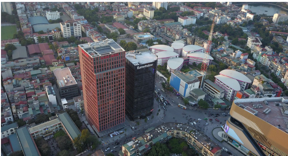
Tòa nhà cao tầng ở Hà Nội sử dụng kết hợp vật liệu kính và các tấm laminate, tấm xi măng cốt sợi
