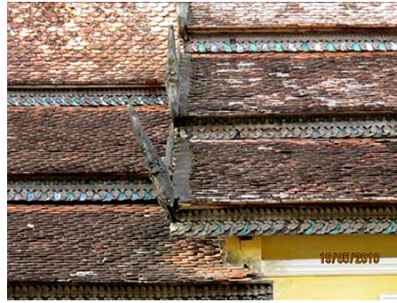
Các cấu kiện mái chính điện chùa Ta Lôn, xã Long Vĩnh, huyện Duyên Hải, tỉnh Trà Vinh đang xuống cấp (tàu mái, rui mái bị thấm dột và mái ngói bị nấm mốc)
