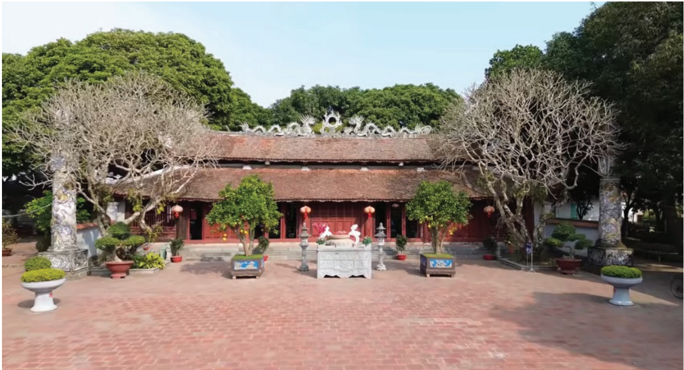
Hình 3. Nhà Bái đường
