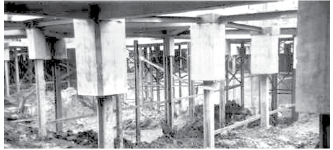
Hình 2. Kingpost phương pháp Top-down
