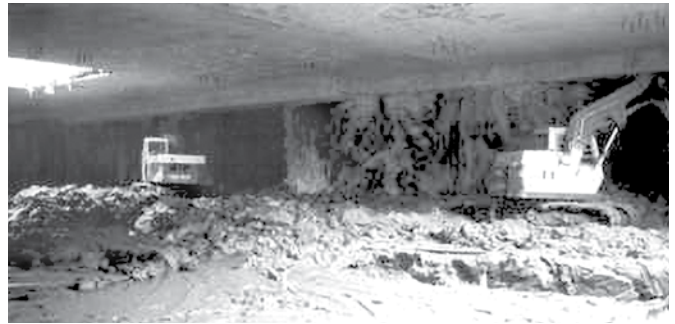
Hình 3. Đào đất trong phương pháp Top-down
