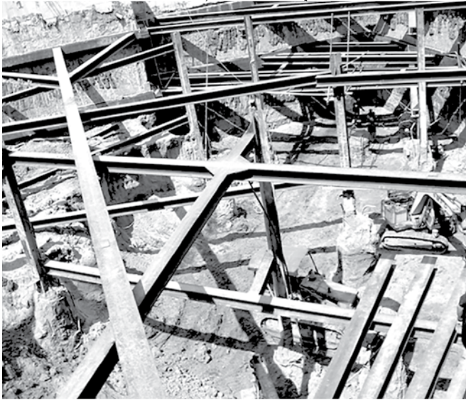
Hình 1. Hệ thanh chống chuyển vị ngang và thi công đào đất trong phương pháp Bottom-up
