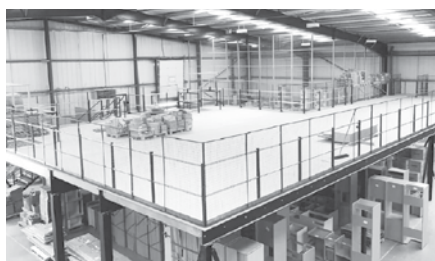
Hình 2. Nhà xưởng công nghiệp có sàn lửng
