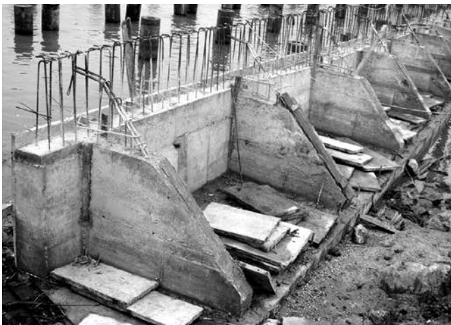
Hình 3. Thi công tường góc kè sau cầu
