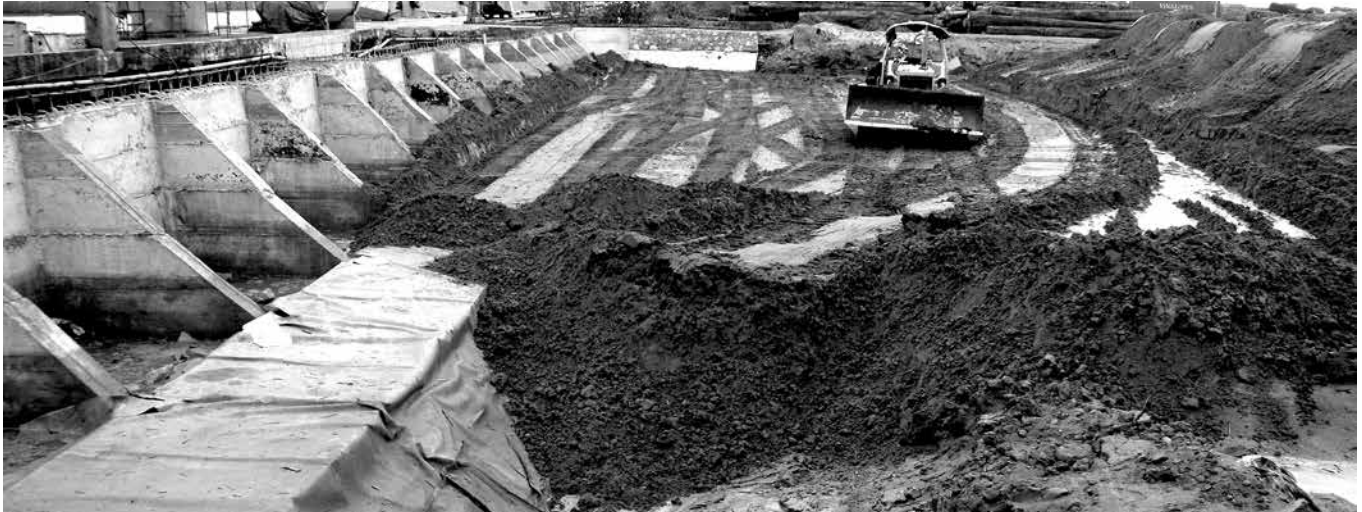
Hình 2. Thi công bãi san lấp sau cầu sau khi làm xong kè sau cầu
